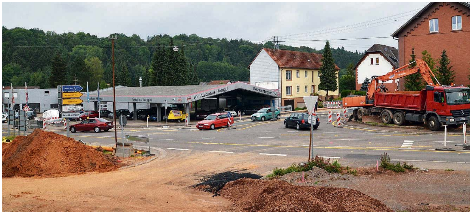
Dieser Anblick gehört bald der Vergangenheit an: An der Kreuzung von Bahnhofstraße und Noswendeler Straße in Dagstuhl soll künftig ein Kreisel für schnelleres Vorankommen sorgen. Am 1. August beginnen die Arbeiten daran. FOTO: NORBERT WAGNER
